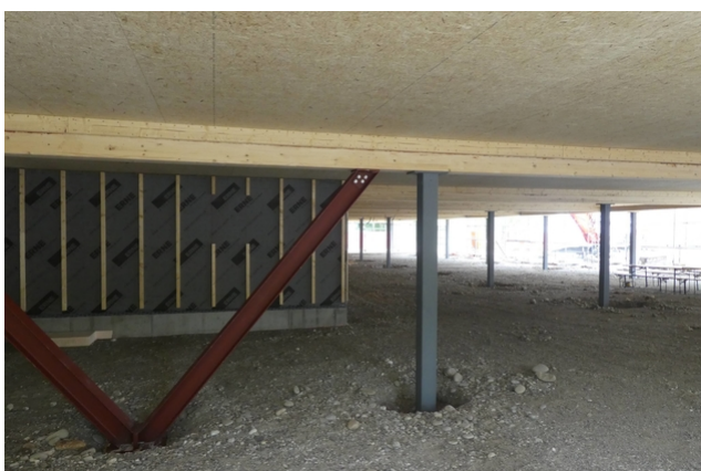
Le bâtiment repose sur des piliers
