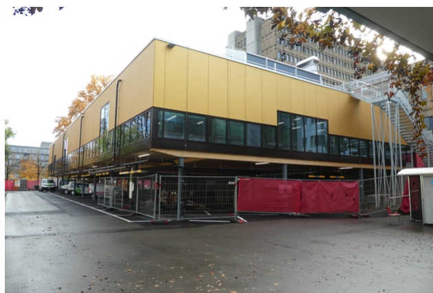
Un bâtiment provisoire à la façade dorée
