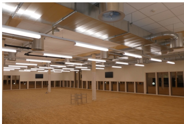
Intérieur avant aménagement
