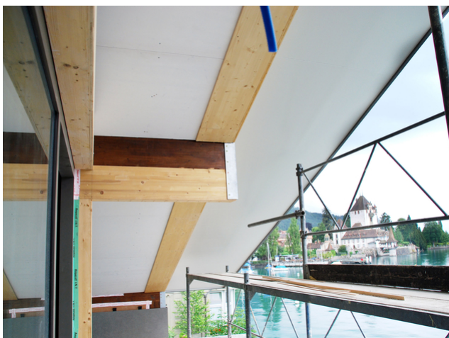
Salle de jardin avec plafond à caissons
