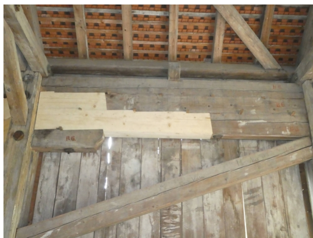
Structure existante et rénovée
