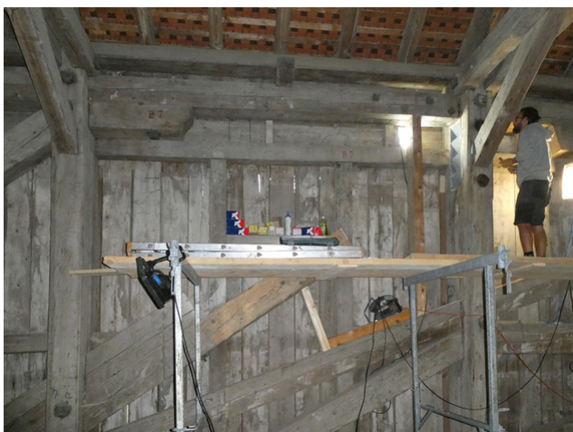
Rénovation des contreforts du pont
