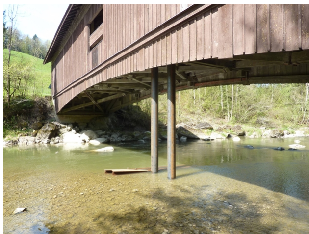
Pieux provisoires de stabilisation
