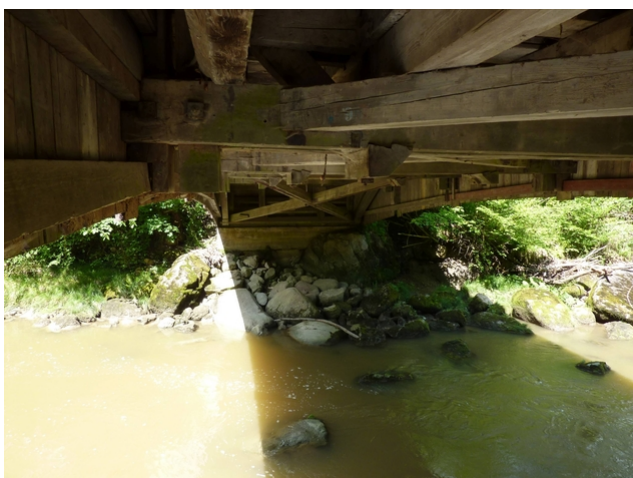
Vue inférieure du pont
