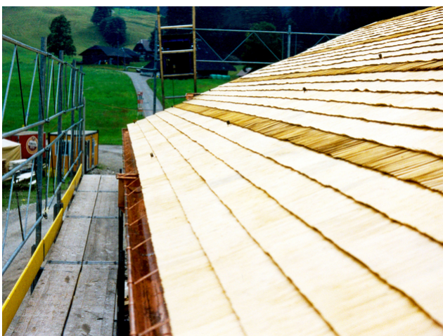
Travaux de bardeaux
