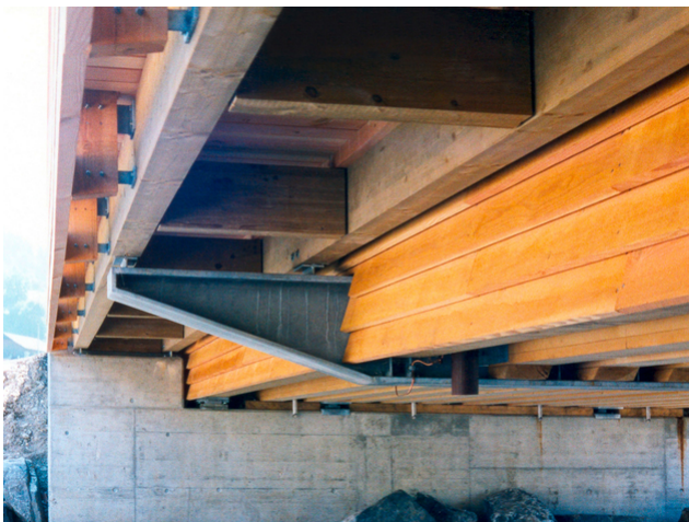
Traverse en acier intégrée
