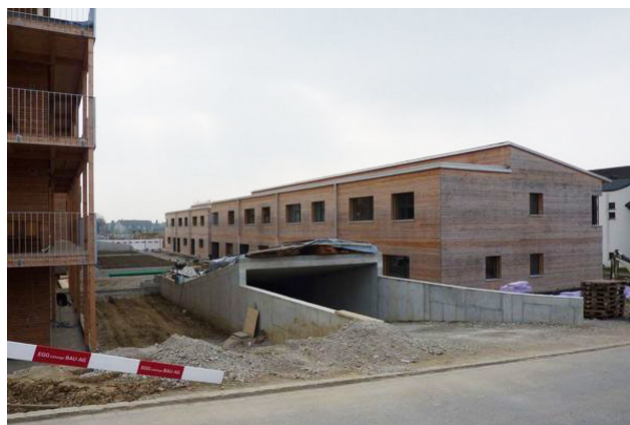
Entrée du parking souterrain
