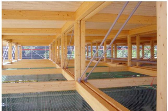
Selon les premiers plans, la structure porteuse du toit du gymnase triple devait être réalisée sous forme de toit en shed avec six grands sheds en construction métallique. Après avoir étudié en détail d'autres variantes de structure porteuse, y compris en bois, le maître d'ouvrage a opté pour un toit plat en bois.
