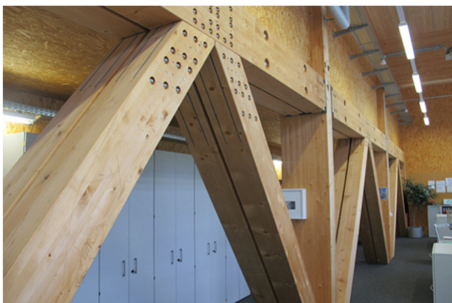
Poutres en treillis dans l'aile des bureaux
