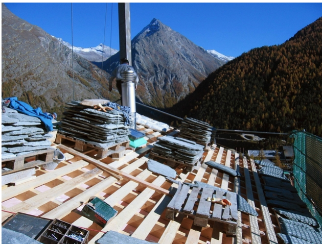
Couverture en dalles de pierre naturelle
