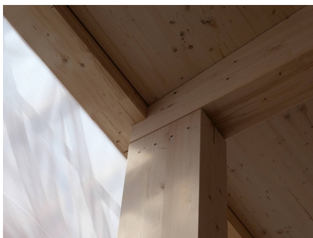
Appui de poutre sur poteau
