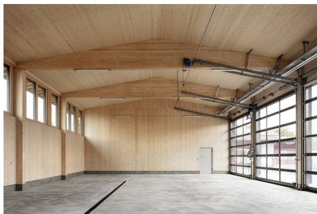
Grands portails fixés à la structure en bois (Lucas Peter, Zurich)
