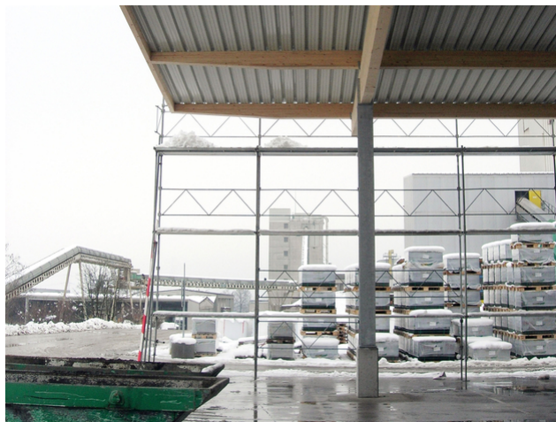
Poteau en acier et poutre en bois
