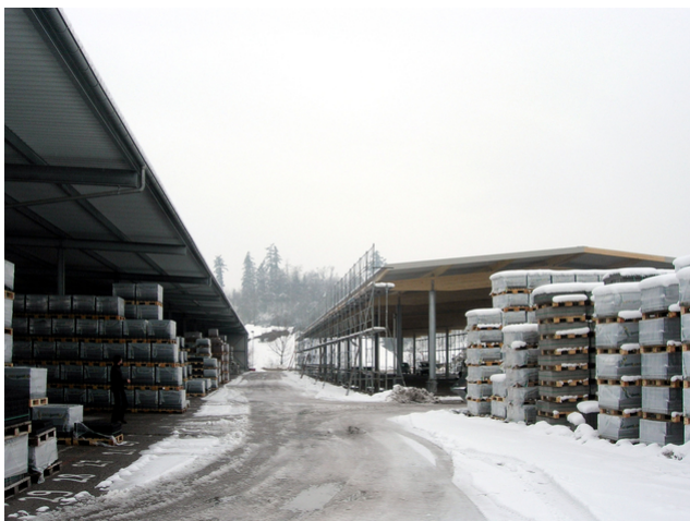
Ancien et nouveau toit
