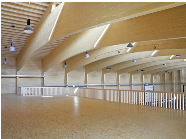
La galerie de la Simmental Arena : vue sur les arcs de liaison
