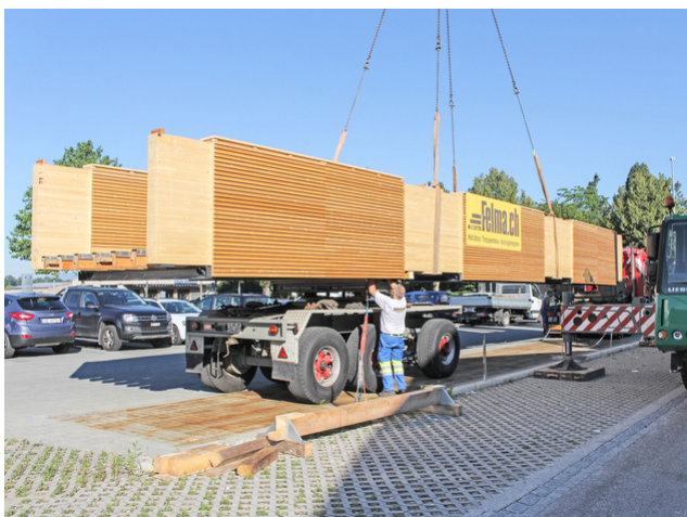
En route : le pont a été transporté en un seul morceau
