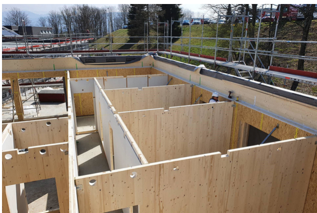
Murs intérieurs en bois lamellé-croisé
