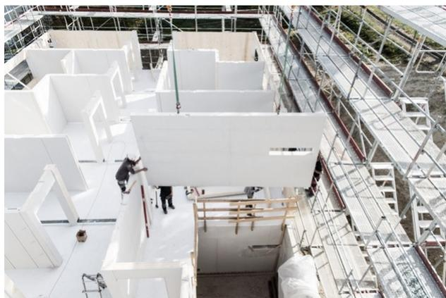
Montage des cloisons intérieures formant compartiment coupe-feu
