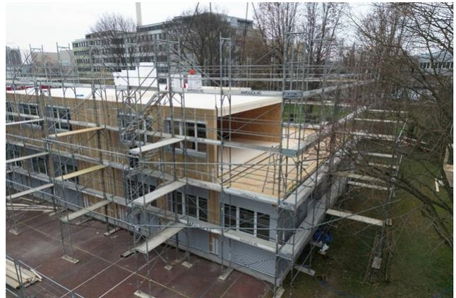
En raison du manque de salles de classe, un bâtiment modulaire de 2 étages a été construit sur un terrain de sport. Timbatec a assisté le constructeur bois en matière de statique, de la sécurité parasismique, la construction et la physique du bâtiment.
