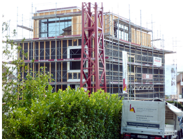
Vue extérieure d'en haut, côté rue, dans le gros œuvre
