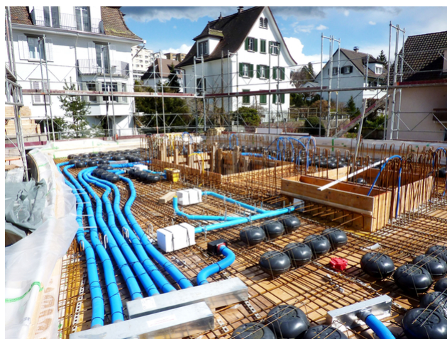
Dalle en béton au-dessus du rez-de-chaussée juste avant le bétonnage
