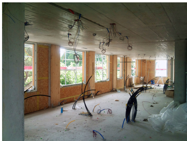
Gros œuvre intérieur
