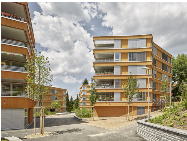
Vue extérieure de la 2e étape
