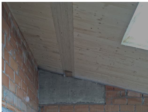
Invisible d'en bas : la panne centrale Kerto a été intégrée dans la structure du toit
