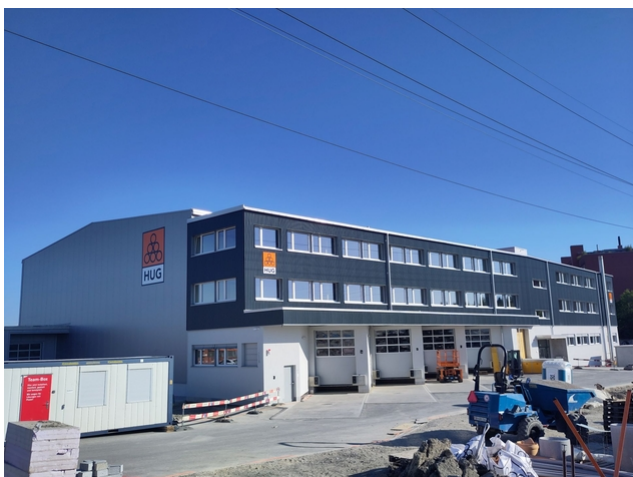
Partie bureaux sur socle en béton armé
