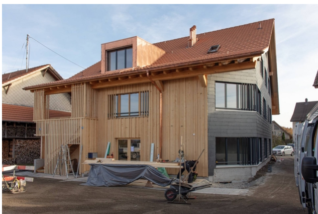
Brandschutzfassade zum Nachbarhaus
