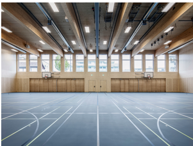
Les murs et le plafond du gymnase sont en bois.
