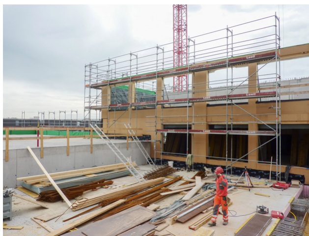
Des éléments en bois pour le nouveau complexe scolaire en construction
