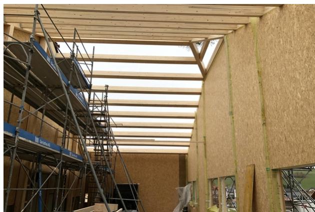
Extension côté pignon
