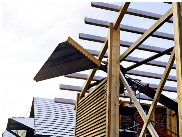
Montage des éléments muraux
