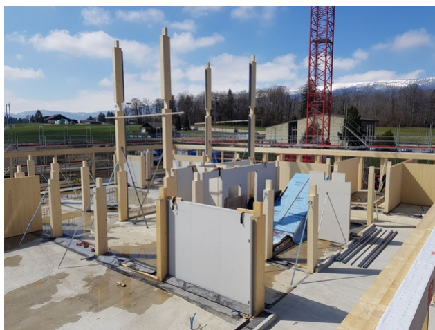
En cours de montage du rez-de-chaussée.
