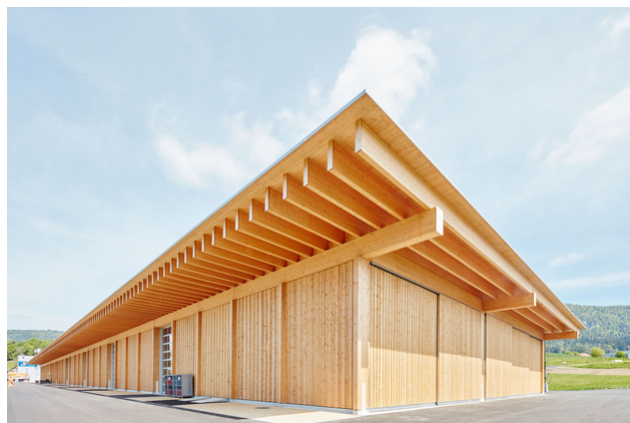
Structure porteuse empilée en croix : les poutres du toit reposent sur les pannes
