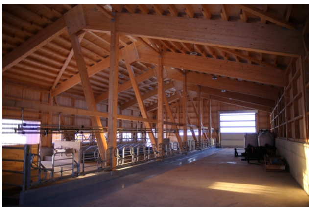
Construction à ossature dans une étable en libre parcours
