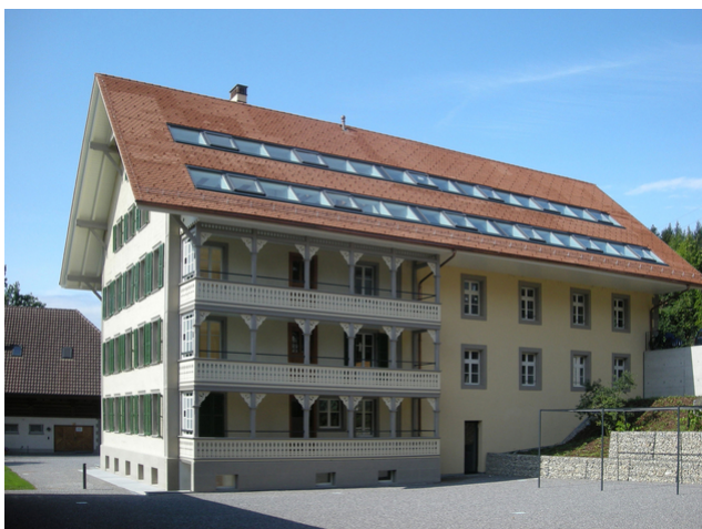
Bâtiment du moulin rénové
