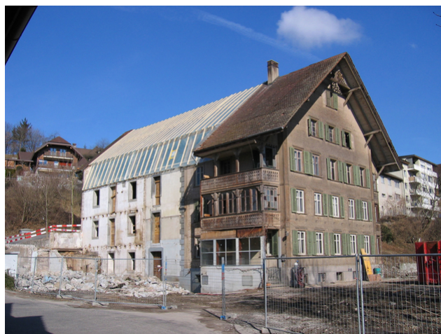
Moulin avant la rénovation
