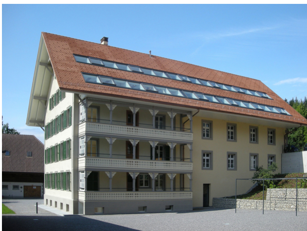
Bâtiment du moulin rénové
