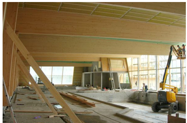
Vue intérieure du gros œuvre
