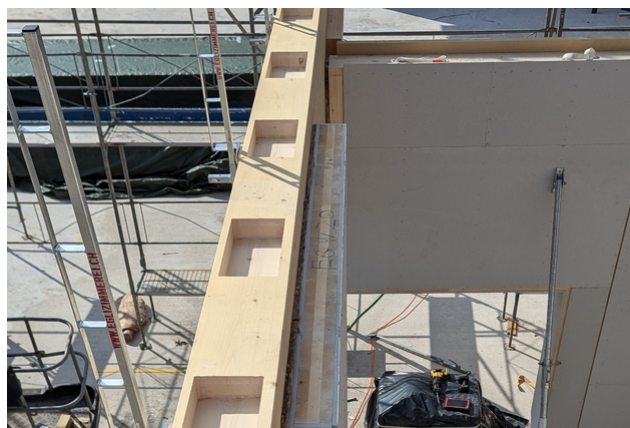
Poches fraisées destinées à recevoir les cames de cisaillement de la poutre de Vierendeel
