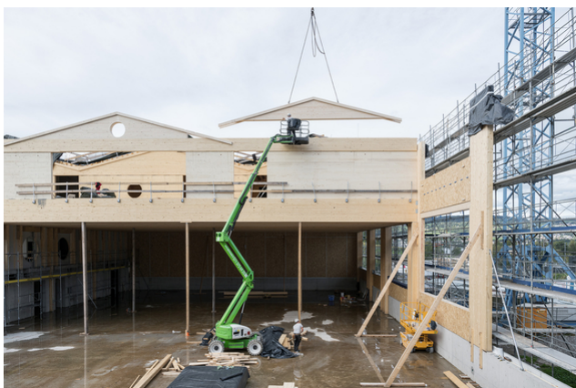
Montage d'une construction en bois : la structure de la salle de sport est en cours de montage
