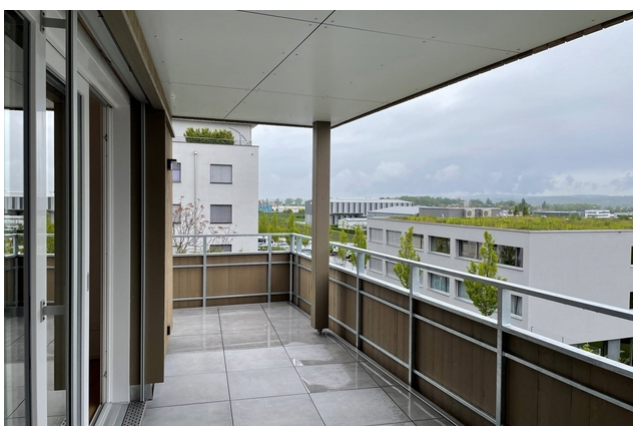
Vue extérieure du balcon
