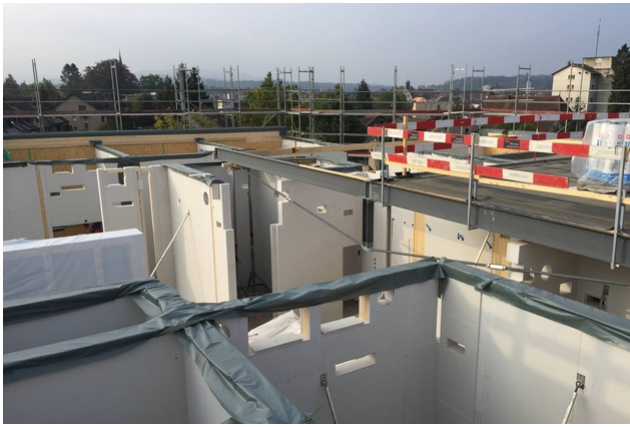
Installation de la poutrelle sous-tendue
