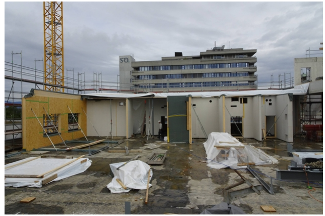
Éléments de paroi intérieure dressés avec les évidements préparés pour les nombreuses installations
