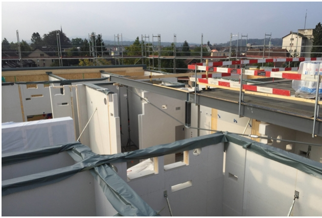
Installation de la poutre sous-tendue
