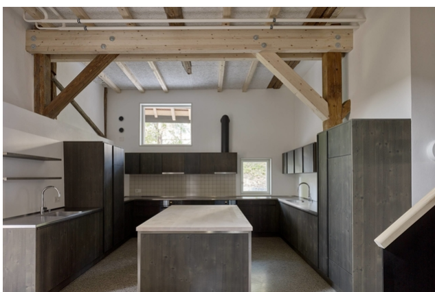
Structure porteuse renforcée au-dessus de la cuisine
