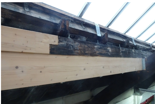
Remplacement des pannes chevron
