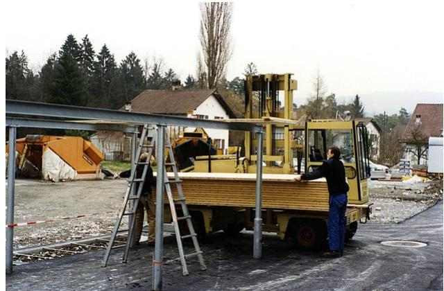
Les architectes avaient en tête une plaque de bois posée sur deux poutres en acier - d'une portée de 4,50 mètres. Le panneau devait avoir une épaisseur maximale d'environ 4 cm et être recouvert de végétation. Impossible à réaliser en l'état, car avec une construction de moins de 110 mm d'épaisseur, la flexion aurait été trop importante. Or, une telle épaisseur n'aurait été satisfaisante ni sur le plan esthétique ni sur le plan économique.
