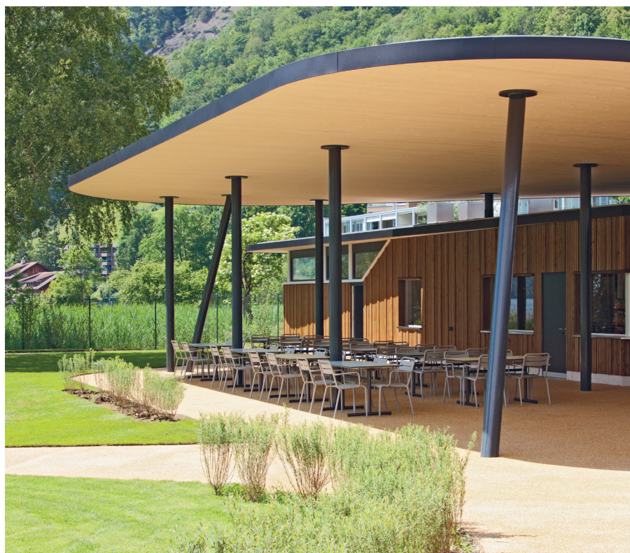
Mit dem TS3-System, einer Entwicklung von Stefan Zöllig, können flächige Holzdecken verbaut werden. Die filigrane Konstruktion erweitert die architektonischen Möglichkeiten, wie beim Pavillon im Strandbad Brunnen.
